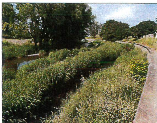
Nánosy se v korytě Bystřice vytvářejí v důsledku jeho uměle vysoké kapacity
